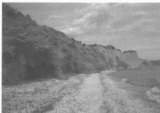
Φωτ. 5. 1999. Άγιος Χαράλαμπος, Μαρώνεια. Δυτικά, ισοροπούσα ακτή με παλιές αστάθειες, και ανατολικά ενεργοποίηση διάβρωσης λόγω κατασκευής κρηπιδότοιχου-κυματοθραύστη στο λιμάνι του Αγ. Χαράλαμπος, Μαρώνειας, ανατολικότερα της φωτογραφίας. Σημειώνεται ότι στην περιοχή υπάρχει παράκτιο ρεύμα από ανατολή προς δύση
