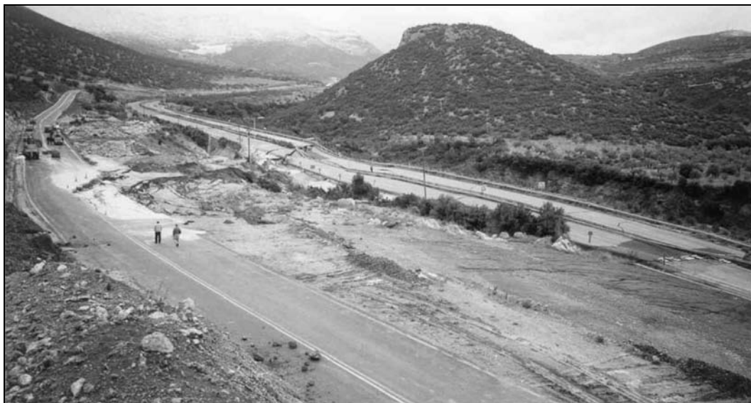
Σχήμα 4. Αποψη της κατολισθημένης μάζας από ανάντη. Διακρίνεται το φρύδι της κατολίσθησης που έφτασε έως το μέσο του ανάντη της Ε.Ο. παράδρομου.
