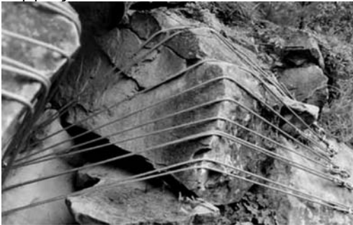
Σχήμα 9. Ενδεικτική θέση με συρματόσχοινα αυξημένης αντοχής ( www.alpideco.it )
